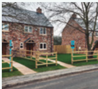
Aquarea toplinske pumpe pružaju grijanje i toplu vodu novim ruralnim kućama, Ujedinjeno kraljevstvo. Aquarea
